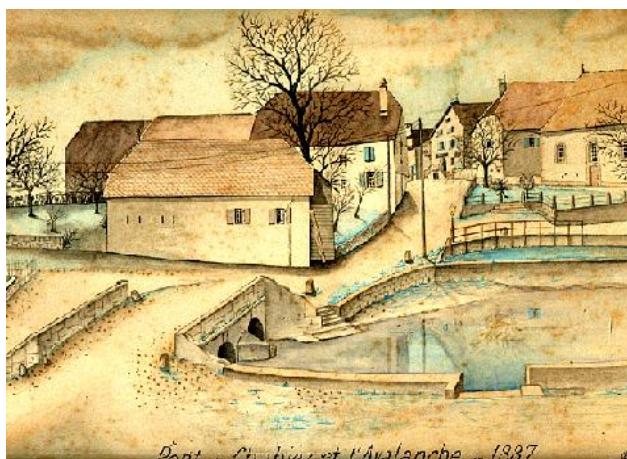
L'ancienne laiterie et le pont de Chabiez
