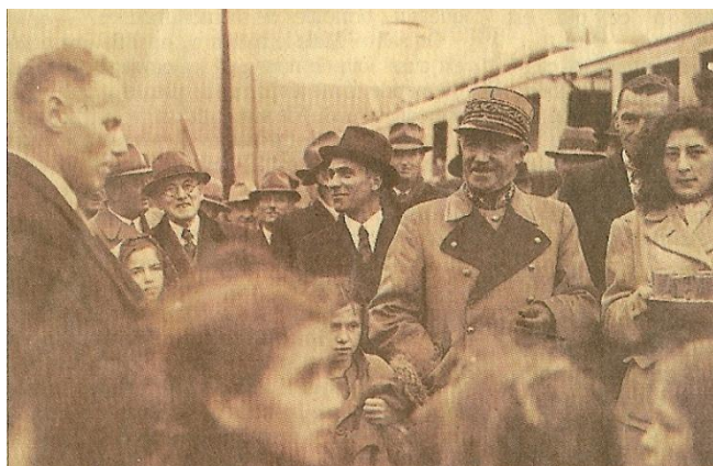
C'est en présence du Général Henri Guisan, que la traction électrique du BAM est inaugurée le 13 novembre 1943.
