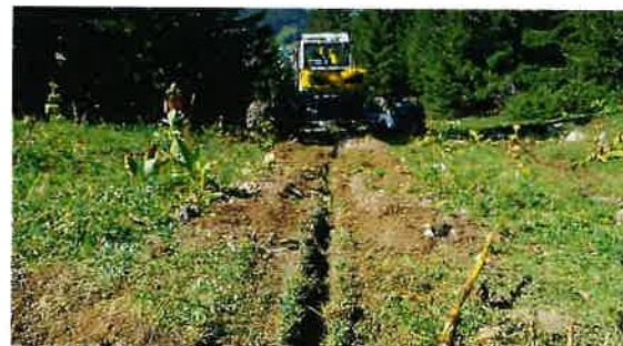
Tranchée, ici largeur de 15 cm
