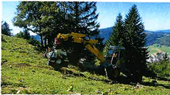
Trancheuse à roche sur pelle araignée
