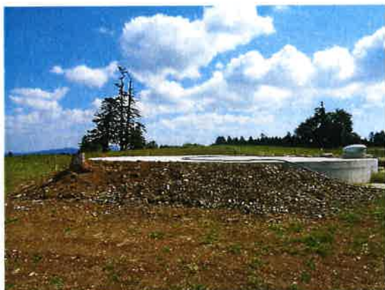
Exemple de citerne enterrée avec mesures d'intégration en cours
